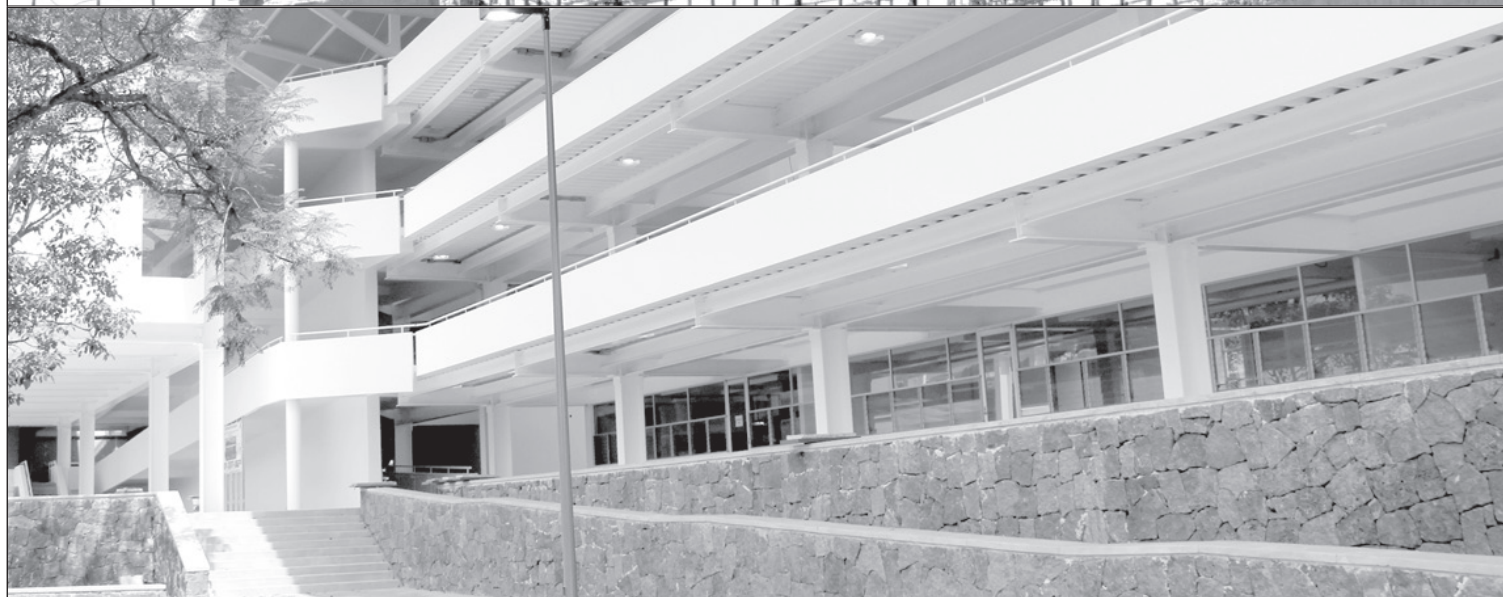
Avances en las obras de la sala de conciertos Tlaqná y la Facultad de Pedagogía
